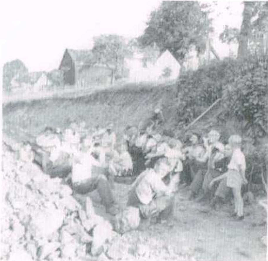
Böschung des Dorfplatzes (heute ALDI) in Blickrichtung der Bäckerei Säger / Fischbach, beim Bau der Dränage.
